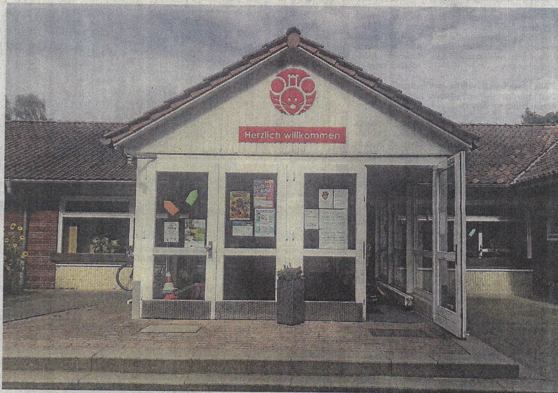
Der älteste Teil der Grundschule Moisburg besteht seit 1948. Im Laufe der Jahre folgten mehrere Anbauten.
